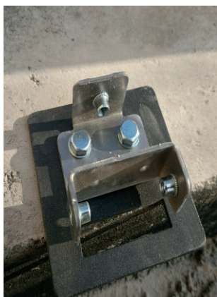
■ Montaż podstawy lampy do podłoża
