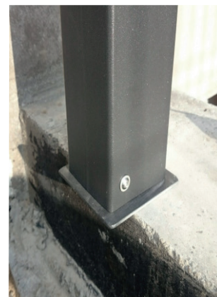
■ Nałożenie korpusu lampy i skręcenie go z podstawą.
