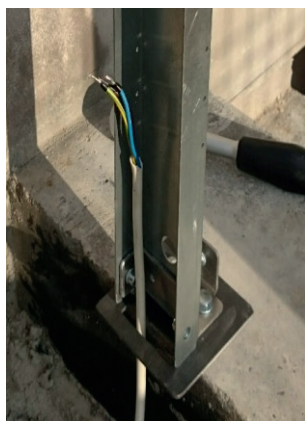
■ Podłączenie zasilania do lampy BOSSPIO i wyprowadzenie przewodów do lampy SIMPIO
